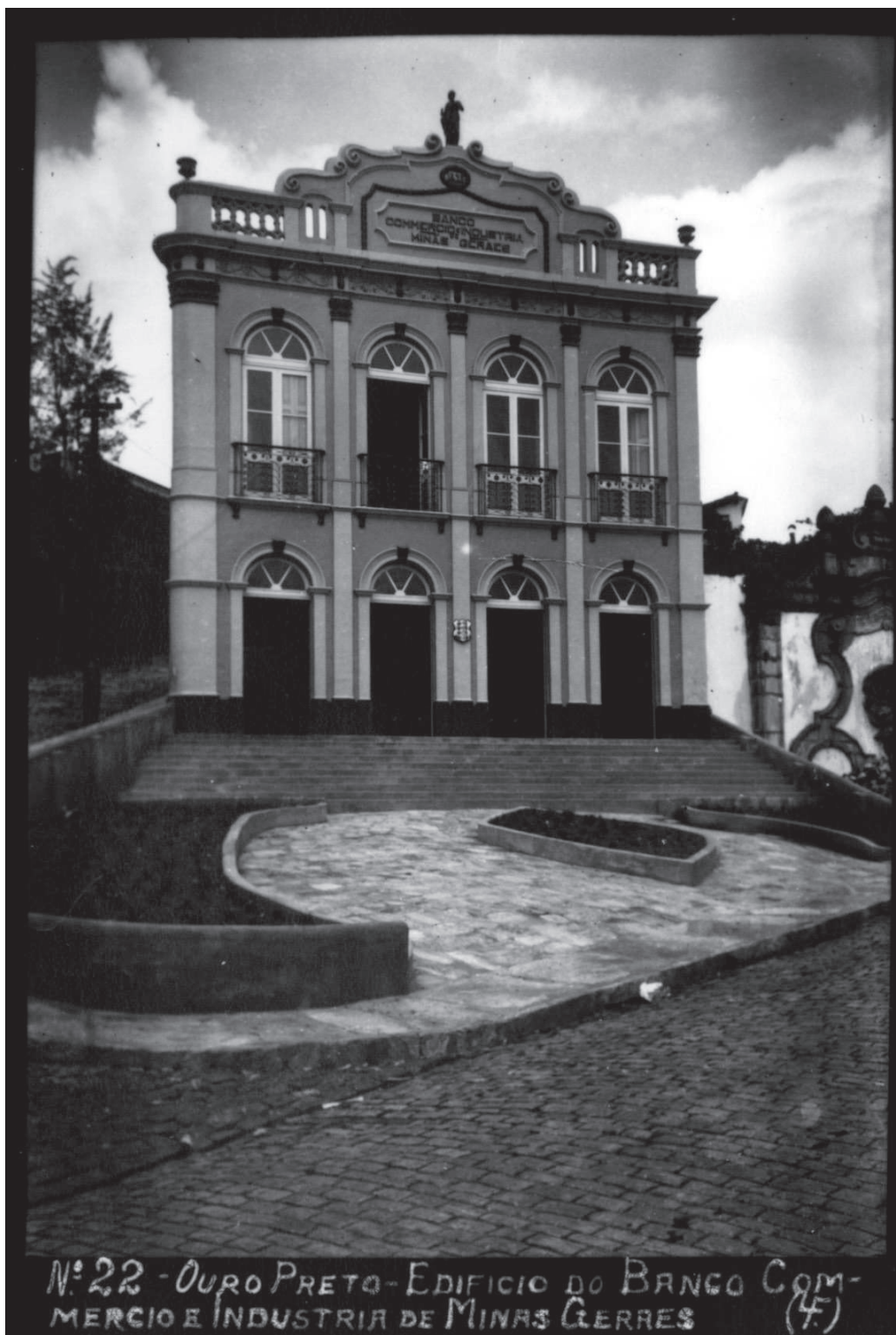
ESTE EDIFÍCIO É ATUALMENTE A SEDE DO MINISTÉRIO PÚBLICO DO ESTADO DE MINAS GERAIS EM OIRO PRETO
