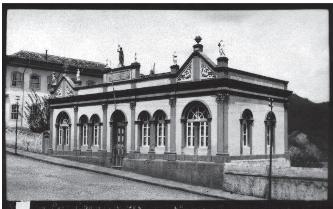
PRÉDIO DO LICEU DE ARTES E OFÍCIOS DE OURO PRETO, DE 1897 A 1953, ATUAL CINE VILA RICA, INAUGURADO EM 1957
